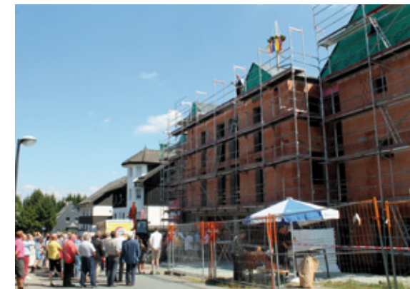
Im Juli 2018 wurde Richtfest im neuen St. Liboriushaus in Winterberg gefeiert. ■
